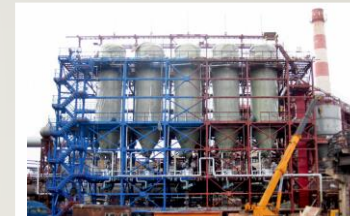
Шефмонтажные и пуско-наладочные работы
