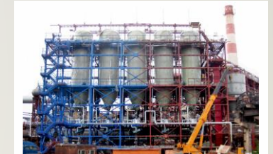
Шефмонтажные и пуско-наладочные работы
