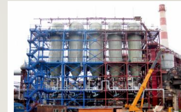
Шефмонтажные и пуско-наладочные работы
